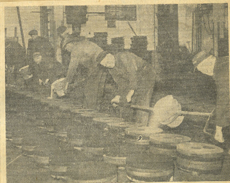
Gjutning vid Br. Anderssons gjuteri.
