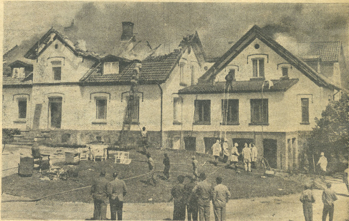
ALLA HJÄLPTE TILL att släcka branden på Näsbyholm och att rädda lösöret. Vindsvåningen blev helt avbränd. Ännu i dag pyr det i askhögar. Nedervåningarna blev helt genomdränkta av vatten vid släckningen
