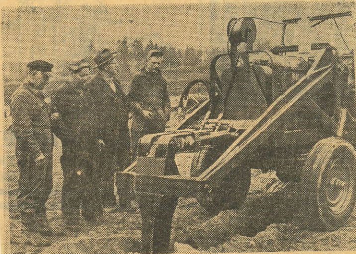
BM 35 arbetar med grävning för kabelnedläggning. Fabrikör Hilding Hansson tredje man från vänster
