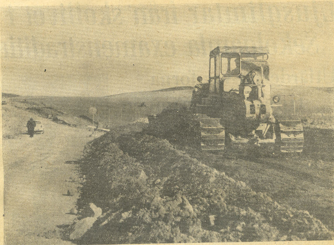
Vägarbete vid Lemmeströ backar.
