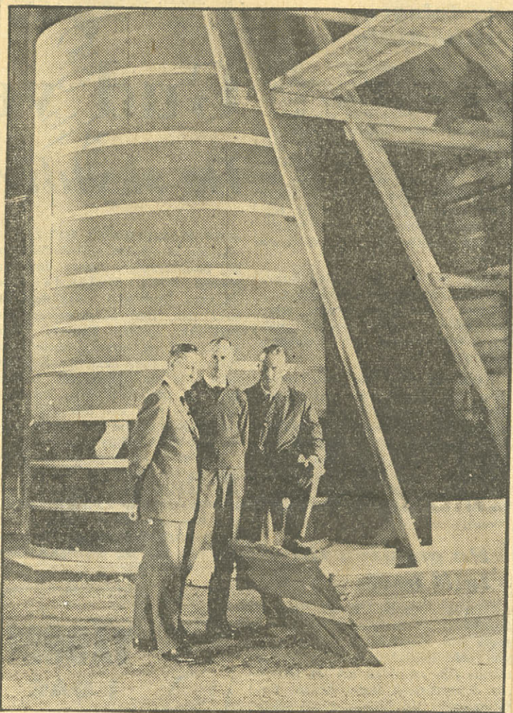
Satstorken från Rydsgård har formen av en cylinder och är utförd i perforerat board-material. Herrarna i förgrunden är fr. v. konstruktören Joel Rosengren, lantbr. Åke Nilsson och agr. Erik Johansson, Oxie.
