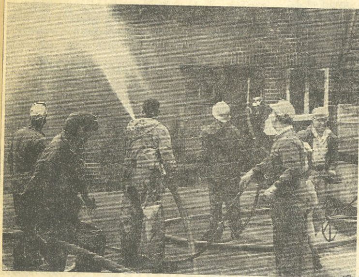
En bild från släckningsarbetet.
