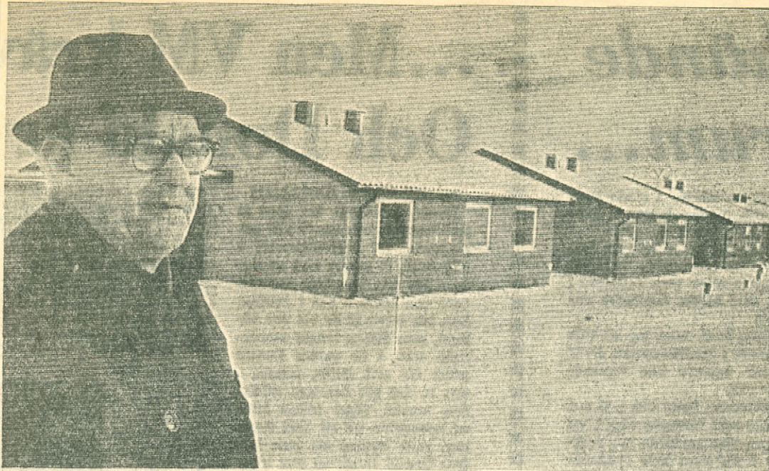
Fastighetsförvaltare Erik Lindskog vid en av husraderna utmed Lavendelvägen i Fridhemsområdet. En husrad med exakt samma utseende utmed Hasselstigen är den sista i 100-lägenhetsprojektet och blir inflyttningsklar vid nästa månadsskifte.
