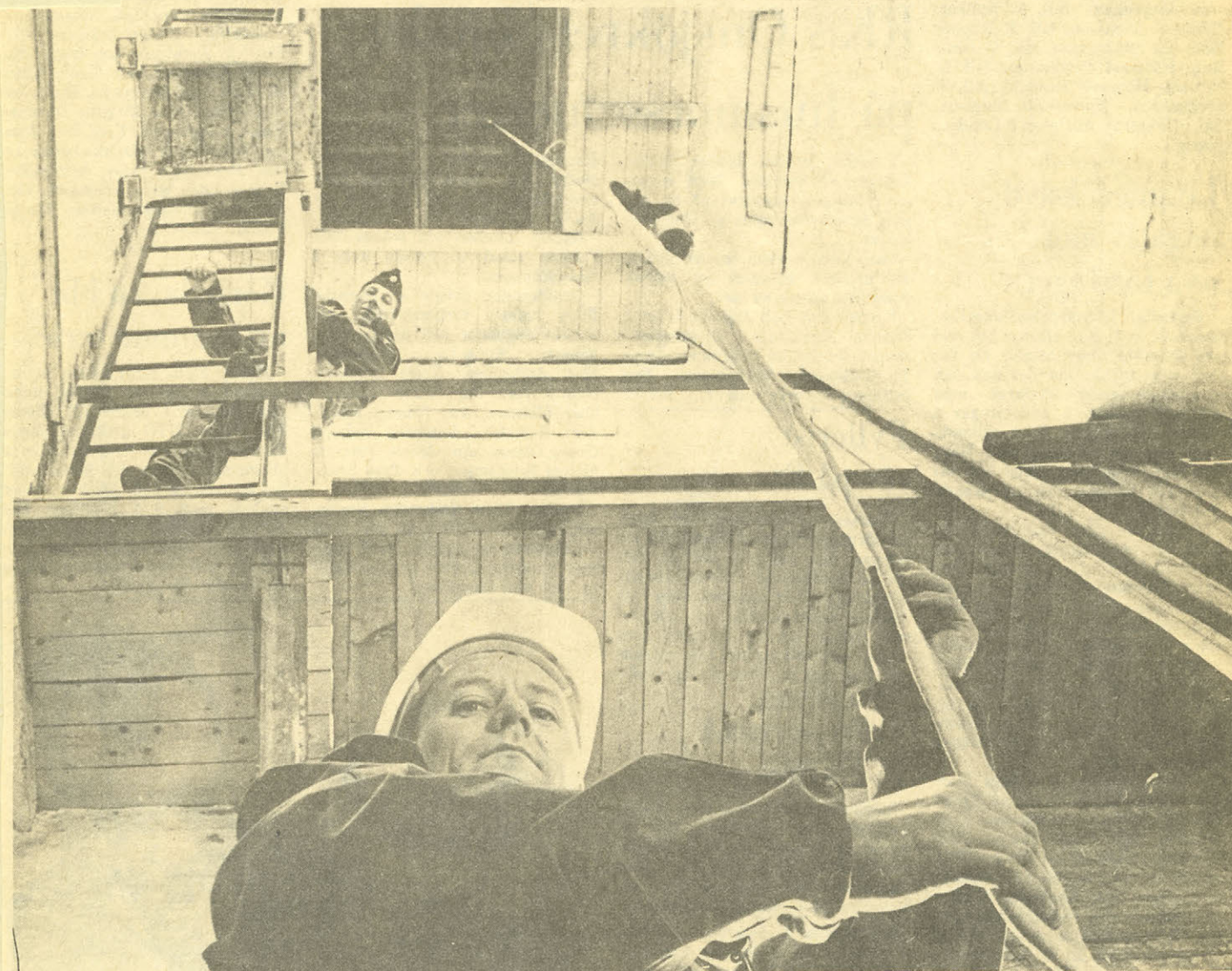
Interiör från brandtornet i Skurup: Bräckliga räck och plattformar. Närmast kameran Alf Karlstedt och Nils Nilsson hänger upp slangar till tork.
