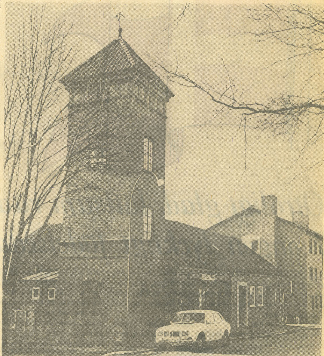
Exteriör av Skurups brandstation
