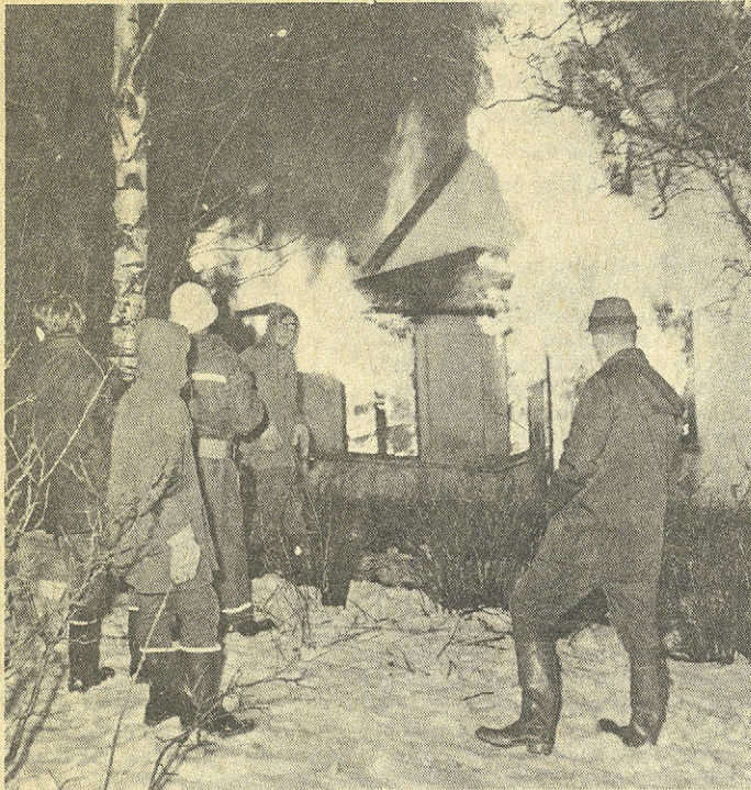
Huset stod i vägen för vägen och fick bli övningsobjekt för brandkåren.
