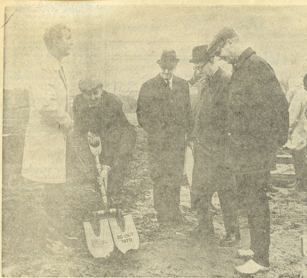
Stiftelsens ordförande, advokat Gunnar Gottfries, tar första spadtaget med den dubbelbladiga spaden under överinseende av fr v VD Kurt Månsson i Harry Karlssons Byggnads AB, fastighetsförvaltare Erik Lindskog, kommunalfullmäktigeordf. Börje Lindén samt Nils Deiml.
