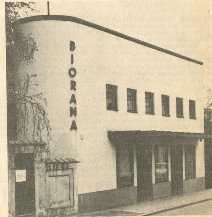
Biorama i Skurup som byggdes år 1935 mötte sitt öde när det bestämdes för några år sedan att den stora hotellbyggnaden inklusive biograf skulle rivas och lämna plats åt ett stort byggnadskomplex — det nuvarande Centrumhuset
