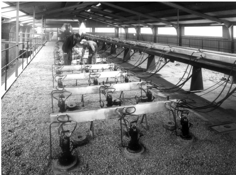
Tegelmästare Curt Olsson t v samtalar med "brännaren" på en av ugnarnas tak i den nya byggnaden. Värmesystemet är i princip lika som före branden. Det var sannolikt en gummislang med eldningsolja till oljebrännarna som spruckit eller lossnat, varpå oljan flödat ut och antänts.
