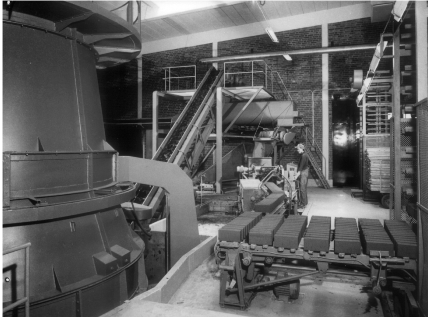
Interiör från maskinhallen. Kammartorken fanns några meter till höger utanför bilden och medgav en kort och effektiv transport av de nyformade teglen. Astrid Wendel övervakar avskärningsbordet.
