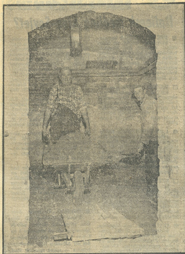
En glimt från den tillämnade matsalen i källarvalven, där utschaktning nu pågår.
