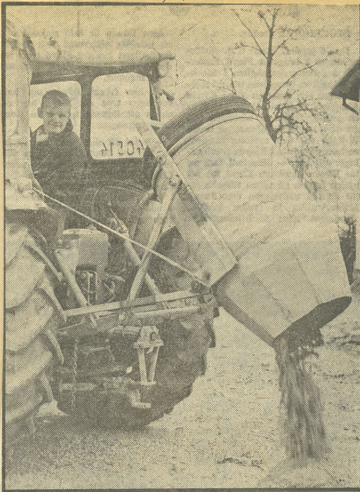
Konstruktören Bertil Andersson visar den praktiska betong- och murbruksblandaren i arbete.
