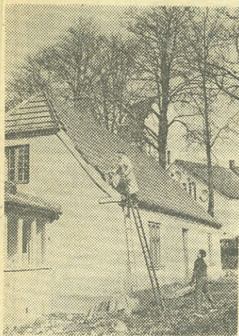
Kantorshuset i Skurup håller på att rivas. Här plockas takteglan ner
