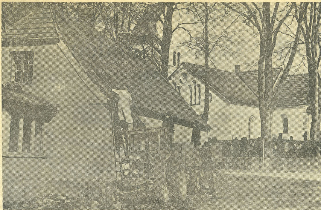
Rivningen har nu påbörjats av kantorsbostaden i Skurup.
