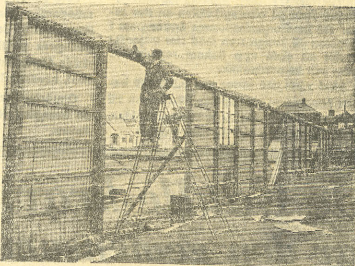
Jörgen Blomqvist skruvar bort den sista skruven innan hela väggen faller
