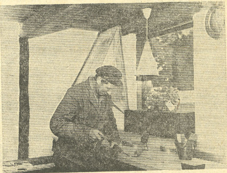
Lennart Bergh bockar till en stupränna som naturligtvis är av koppar
