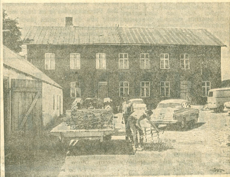
Fattiggården som den ser ut i dag. Till vänster ligger gamla fattighuset, den äldsta byggnaden, och i mitten syns tvåvåningslängan med de 19 rummen.
