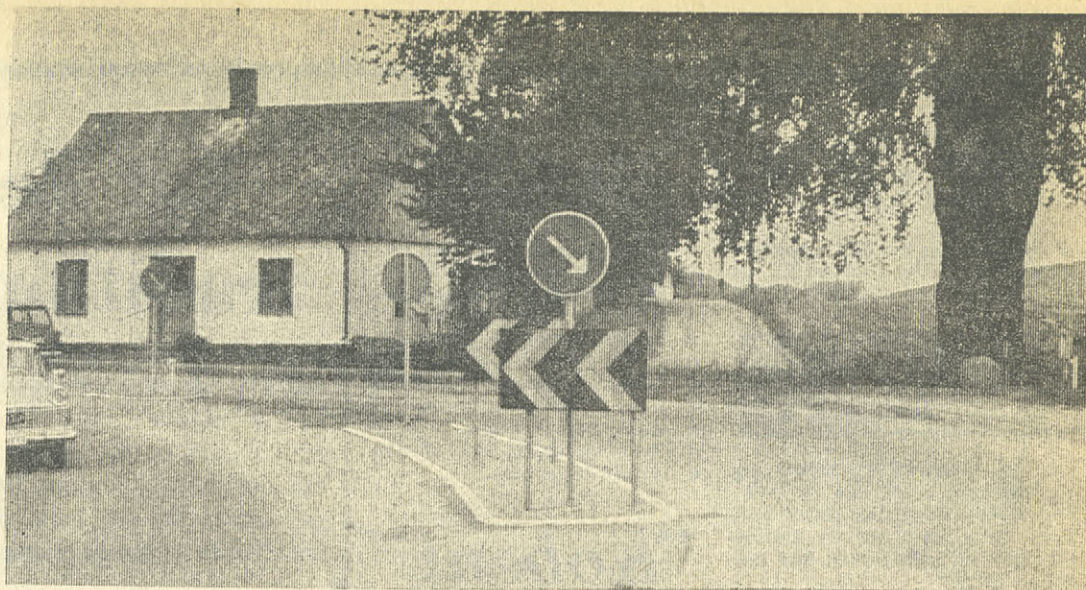
Massor av bilister refar sig på denna virriga placering av märket med vinklarna som visar åt vänster — strax nedanför ett trafikdelarmärke med pil åt höger.
