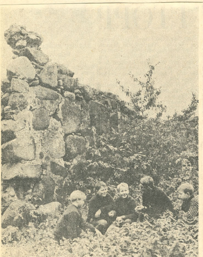
2) Nutidens barn har en spännande lekplats bland ruinerna efter den Börringe sockenkyrka 1584-1787 som i samband med reformationens införande restes efter klosterkyrkan fast på annan plats.
