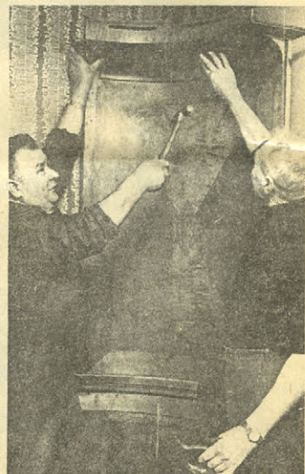
Från snickarmästare Nils A Nilsson och Gösta Ivarsson i färd med att sätta upp inredningen från Drottning Victorias matsal i kaféet i Skurups Folkets park.
