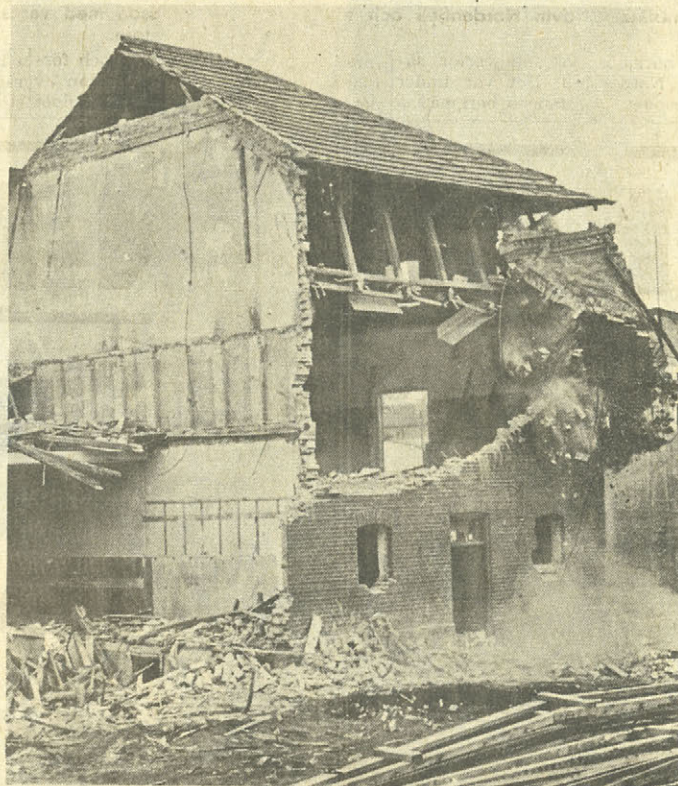
Rivningen av Skurups hotell går in i sitt slutskede.
